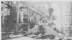
Anselmo Tromp di Mechanical Department poniendo e ultimo pida di e tubo den e blow down system.
